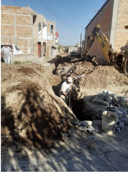
EXCAVACION CE CEPAS
