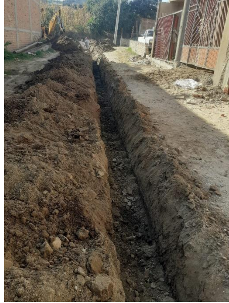
EXCAVACION CE CEPAS
