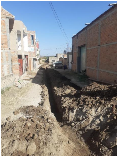
INSTALACION DE TUBERIA
